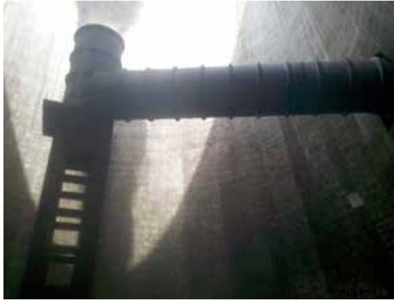
2013: Bis auf Feuchtigkeit und Staub auf der Oberfläche ist der Beton nach wie vor einwandfrei.
