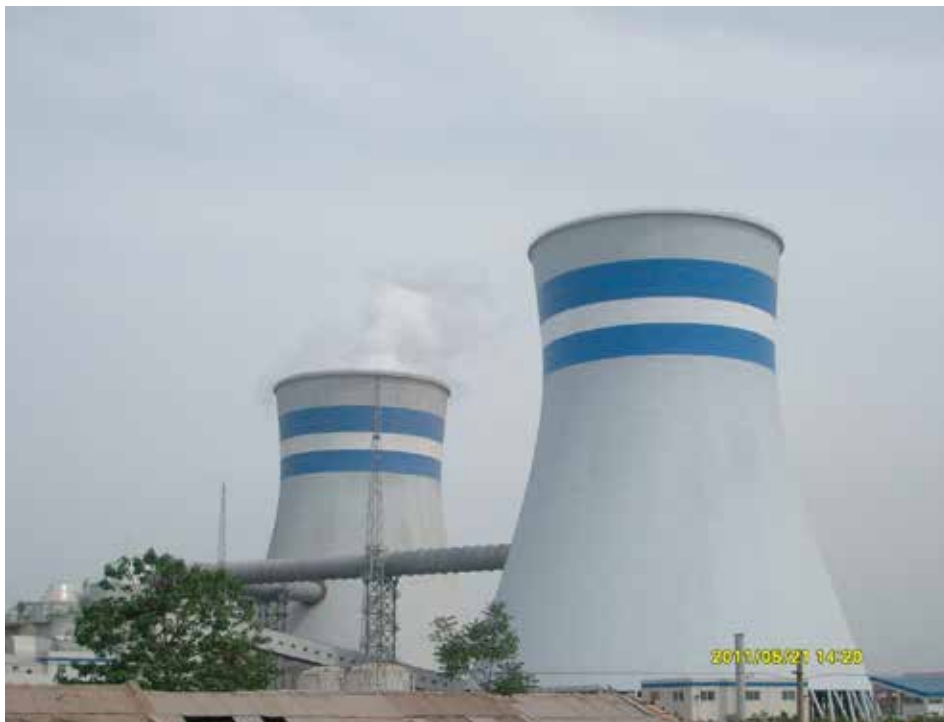
Kühlturm in Shijiazhuang (13 Mio.-Einwohner-Metropole südlich von Peking)
